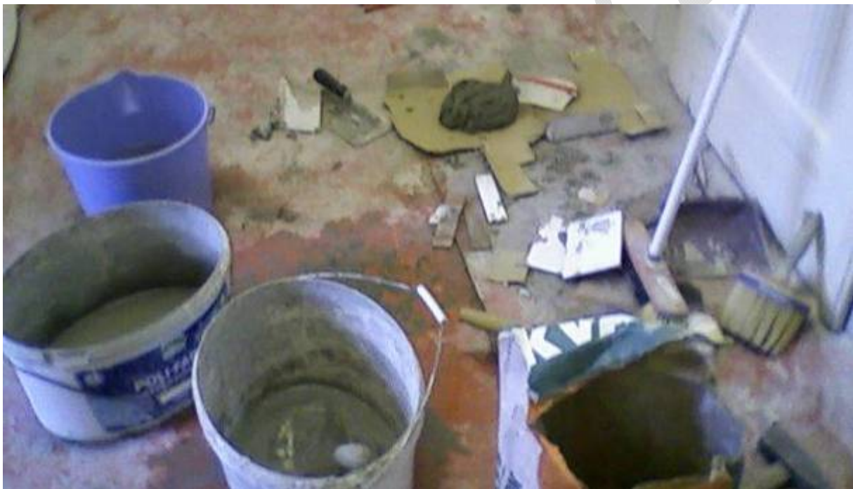
1. ábra. Építési terület a nap végén
